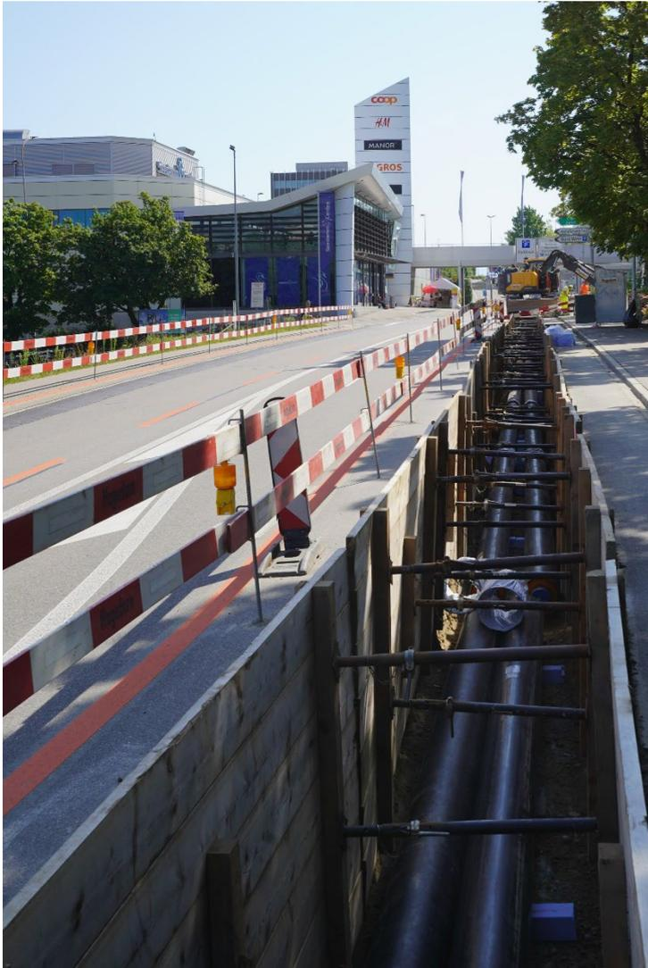
**Bildlegende:** Fernwärmeleitungen (Vor- und Rücklauf) entlang der Gwattstrasse in Pfäffikon.
